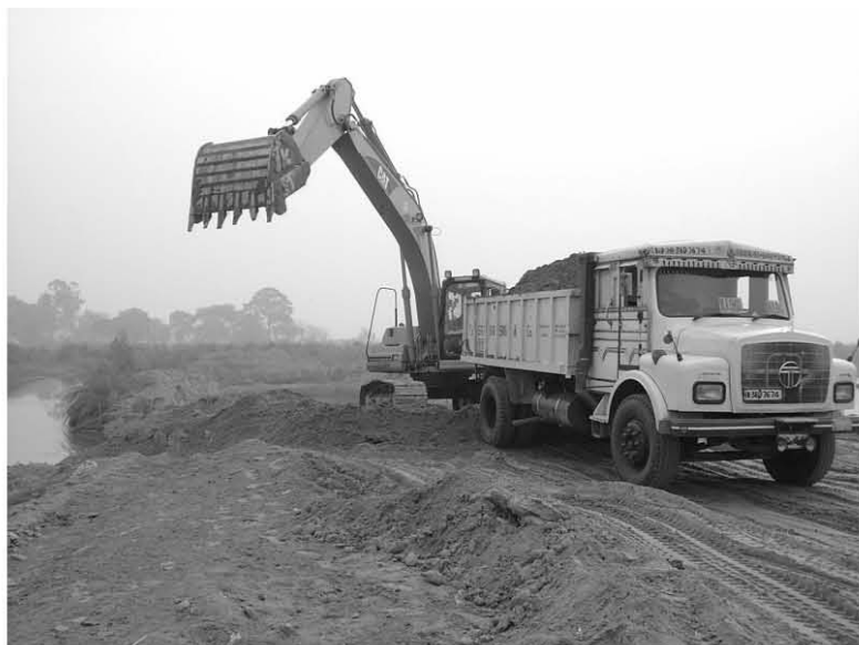
盛土区間(堤体外)
