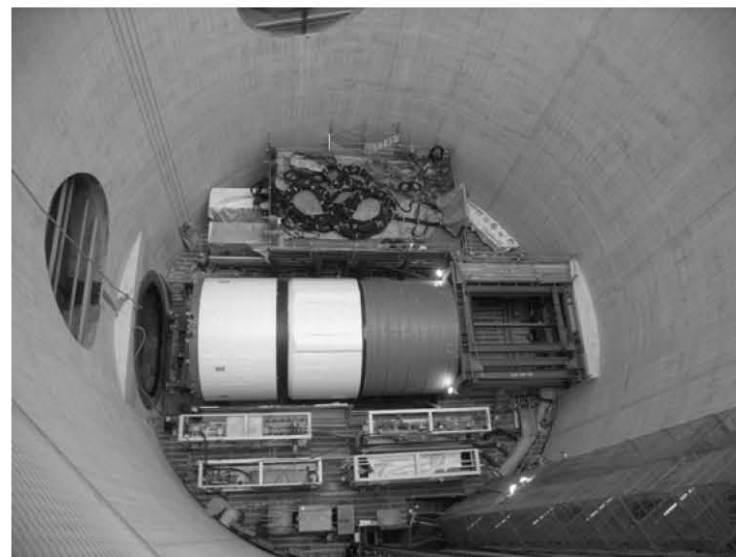
写真(シールドマシン発進状況)
