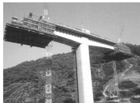
張出し施工イメージ写真
