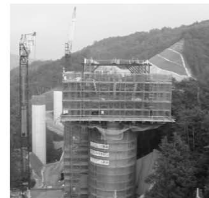
柱頭部施工イメージ写真
