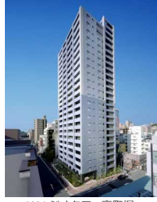
2004 シオタワー京町堀
