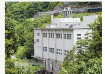
15 黒部川第三発電所
