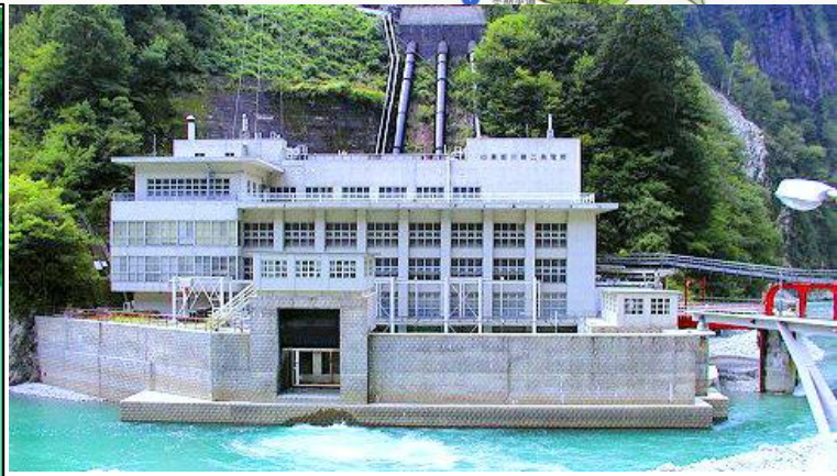
黒部川第2発電所
