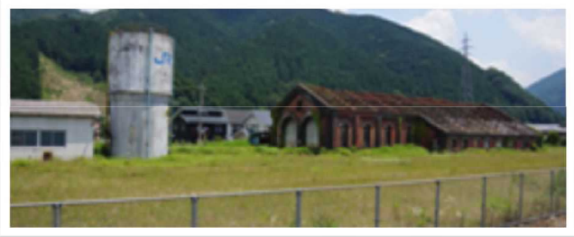
和田山機関庫及び給水塔
