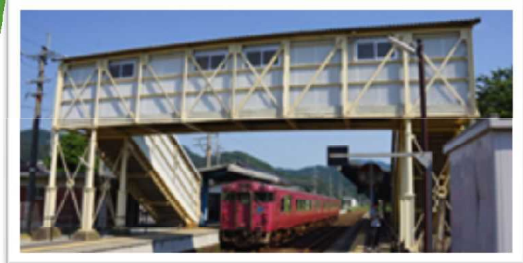
竹野駅跨線橋
